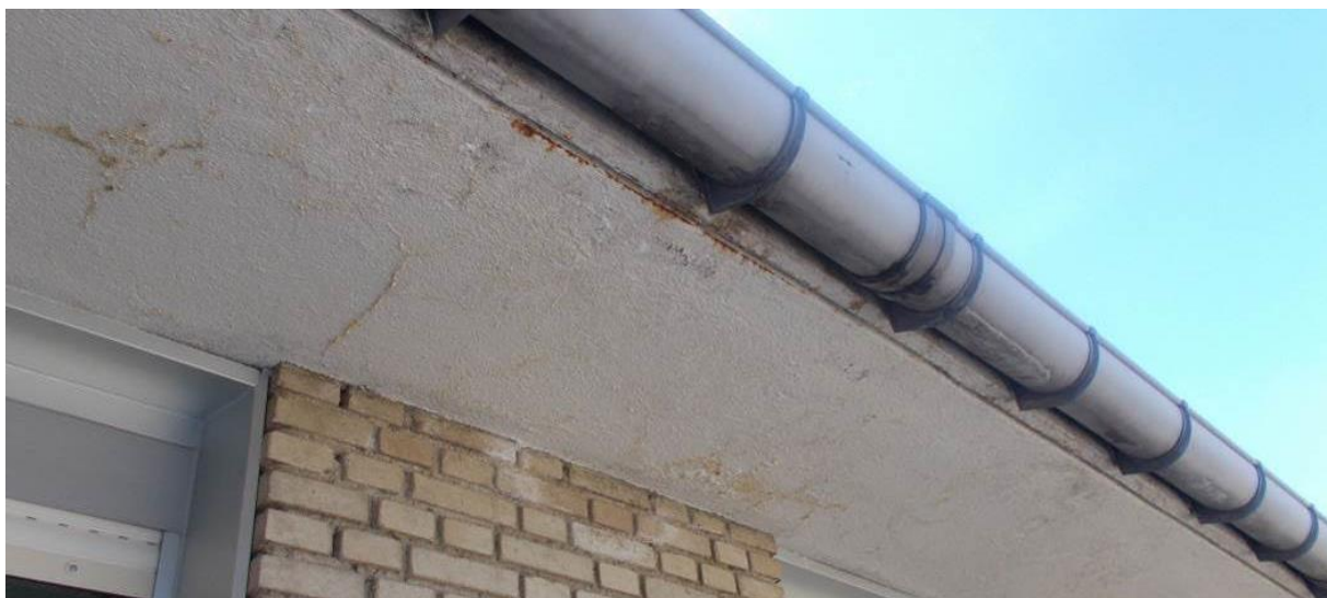
Ilustración 42. ALEROS EN MAL ESTADO. MÓDULO K.
