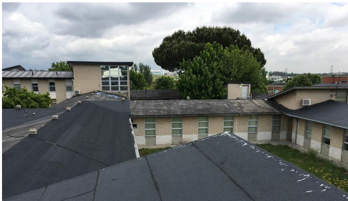
Ilustración 28. CUBIERTA INCLINADA ASFÁLTICA CON FILTRACIONES DE AGUA
