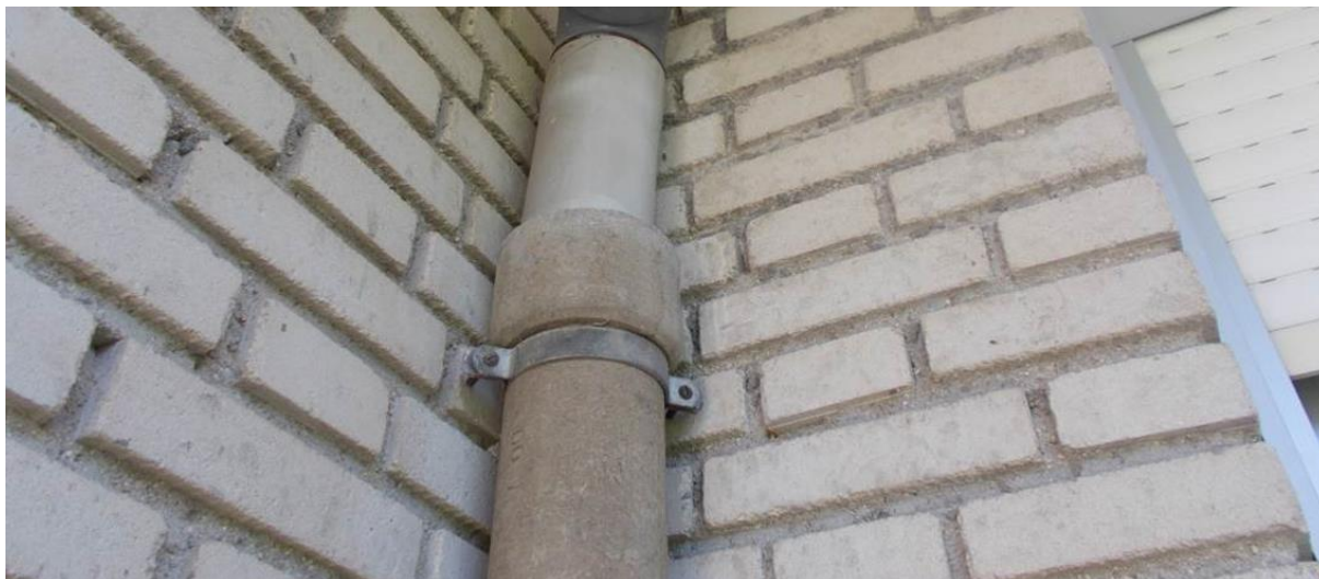
Ilustración 38. BAJANTES DE FIBROCEMENTO. MÓDULO L.
