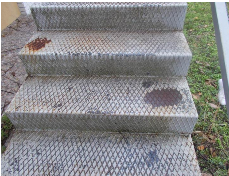
Ilustración 20. ESCALERA EXTERIOR OXIDADA. MÓDULO G.
