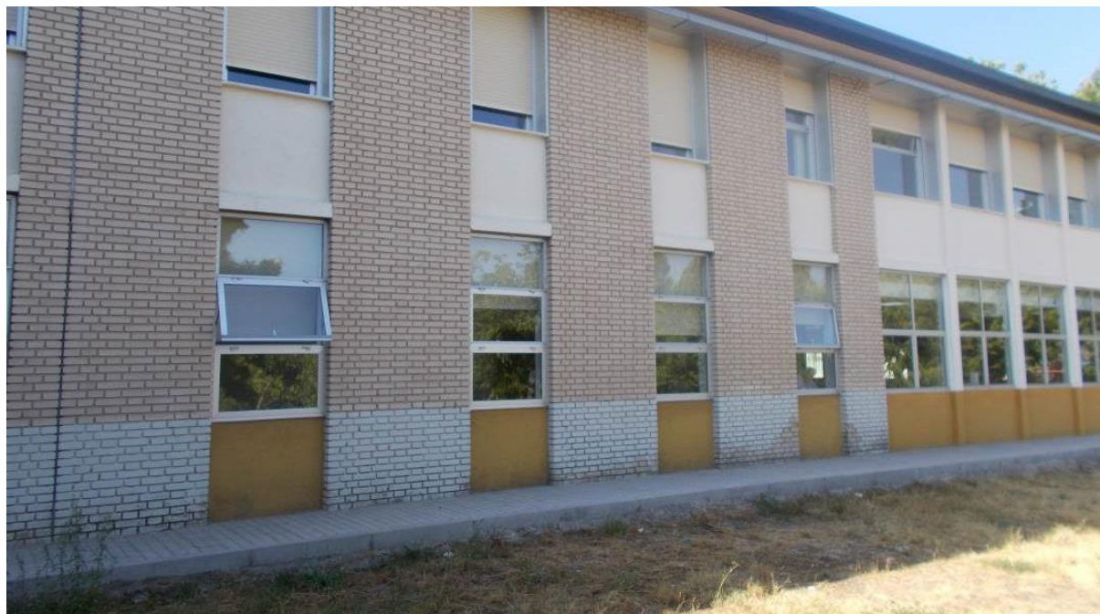
Ilustración 40. HUMEDAD EN ARRANQUE DE MUROS. MÓDULO A.
