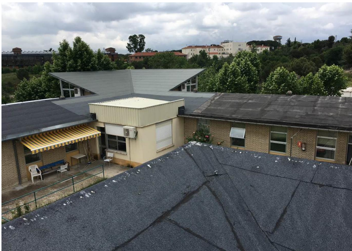
Ilustración 27. CUBIERTA INCLINADA ASFÁLTICA CON FILTRACIONES DE AGUA EN MÓDULO E
