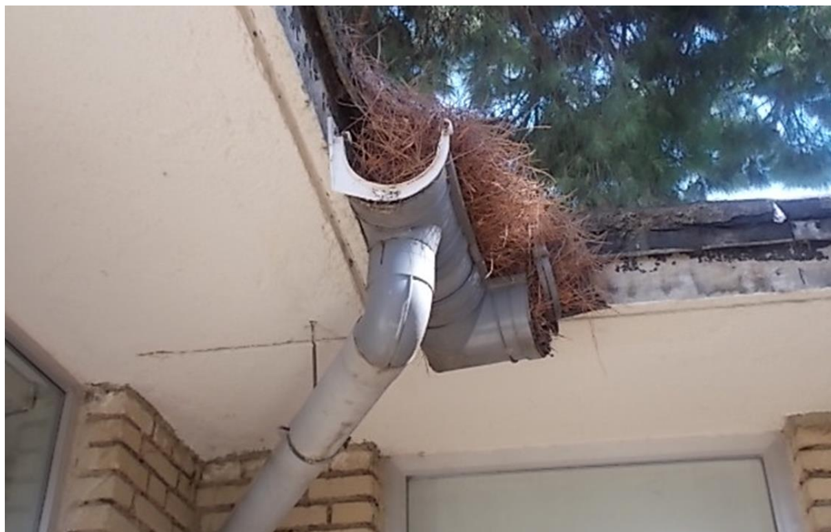
Ilustración 32. CANALÓN OBSTRUIDO. MÓDULO D.
