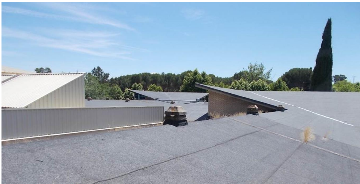
Ilustración 30. CUBIERTA INCLINADA ASFÁLTICA CON FILTRACIONES DE AGUA EN MÓDULO N
