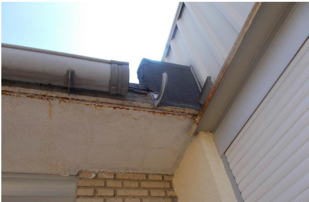
Ilustración 34. CANALÓN DETERIORADO. MÓDULO K.
