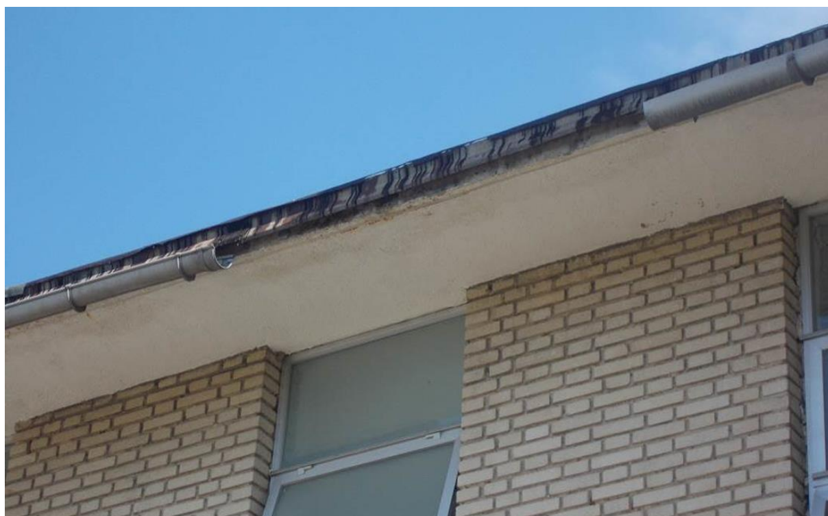
Ilustración 33. CANALÓN DETERIORADO. MÓDULO E.
