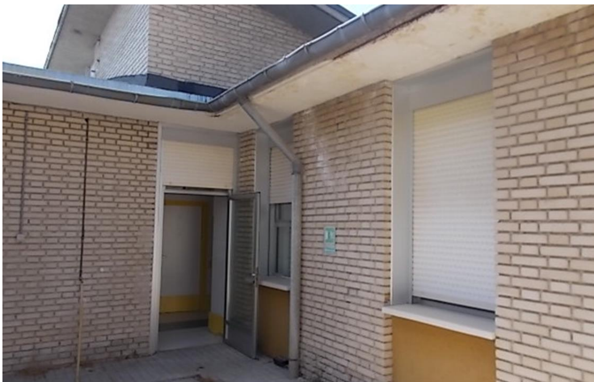
Ilustración 39. BAJANTES DE FIBROCEMENTO. MÓDULO P.
