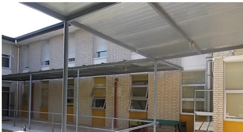
Ilustración 46. MARQUESINA FIBROCEMENTO. MÓDULO B.
