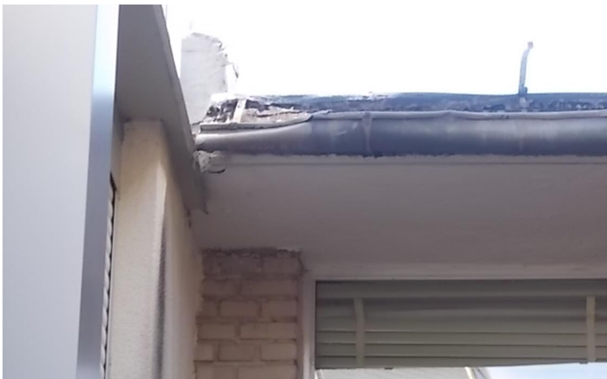
Ilustración 35. CANALÓN DETERIORADO. MÓDULO O.
