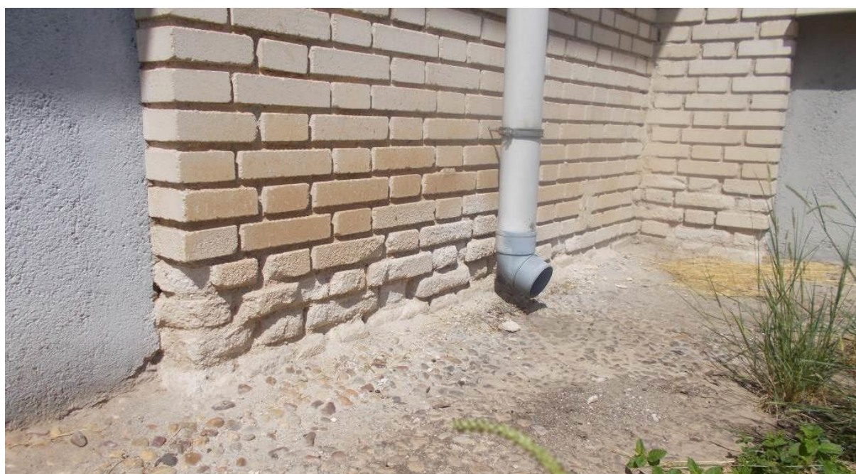
Ilustración 41. LADRILLOS DETERIORADOS EN ARRANQUE DE MURO. MÓDULO K.
