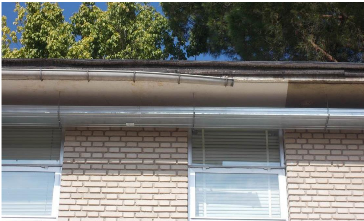
Ilustración 31. CANALÓN DETERIORADO. MÓDULO D.
