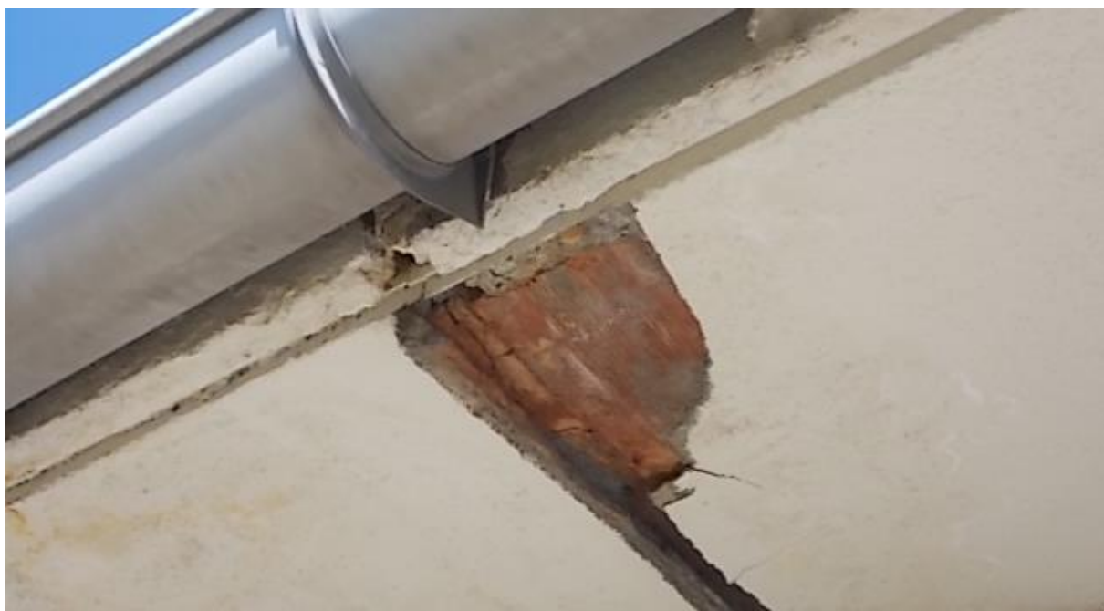
Ilustración 43. ALEROS EN MAL ESTADO. MÓDULO K.
