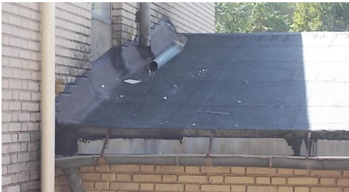
Ilustración 36. CANALÓN DETERIORADO. MÓDULO P.
