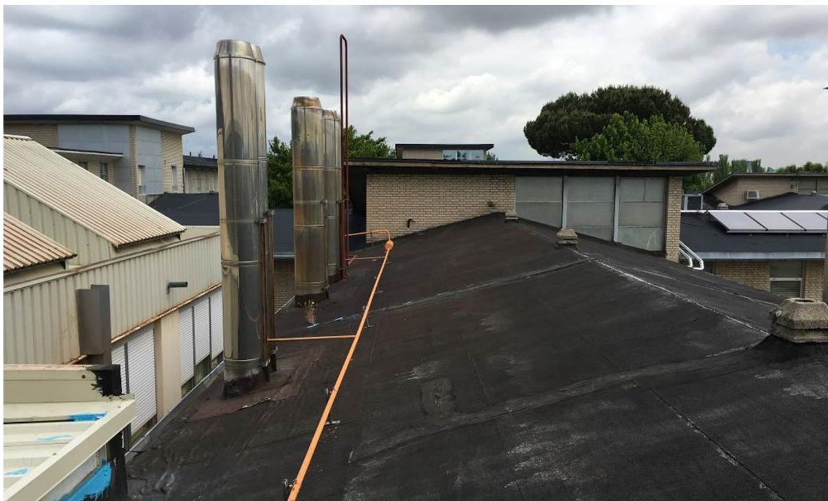
Ilustración 26. CUBIERTA INCLINADA ASFÁLTICA CON FILTRACIONES DE AGUA EN MÓDULO E.
