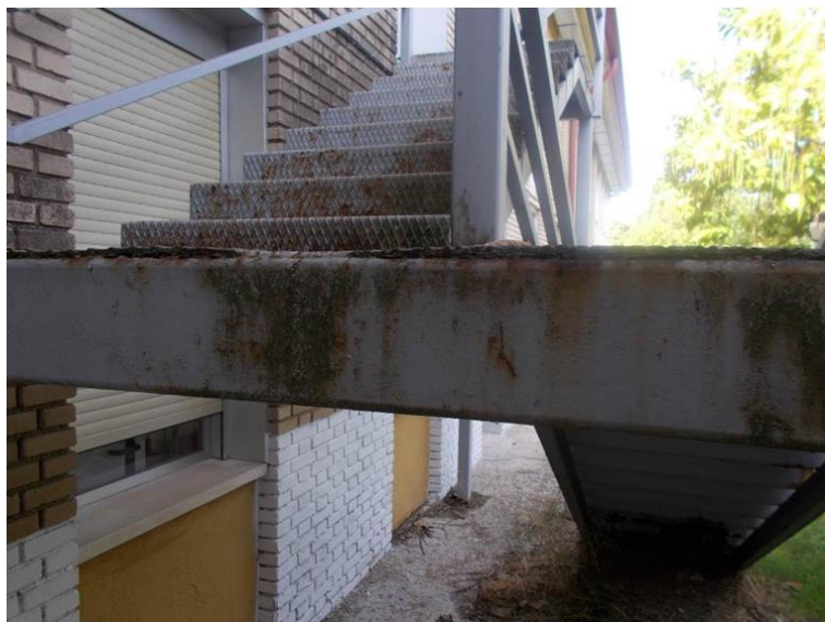
Ilustración 22. ESCALERA EXTERIOR OXIDADA. MÓDULO H.
